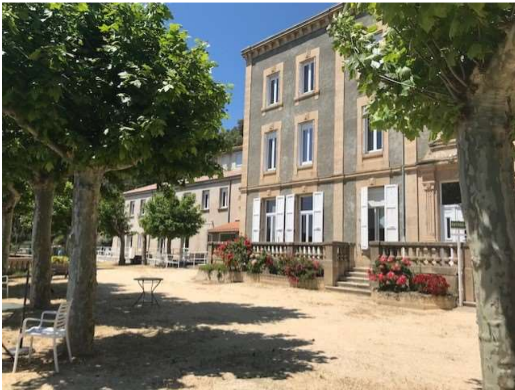
Le bâtiment Le Château au premier plan, et le bâtiment Le Nid en arrière-plan.
